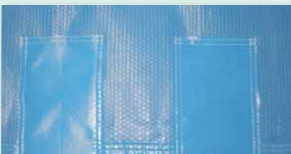
Cajeado de refuerzo para escalera
